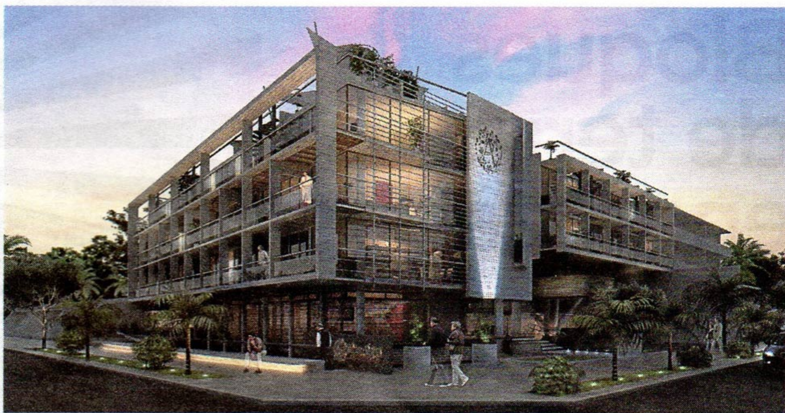
Doble piel. Una pantalla de hormigón armado soporta la malla metálica de los balcones.
