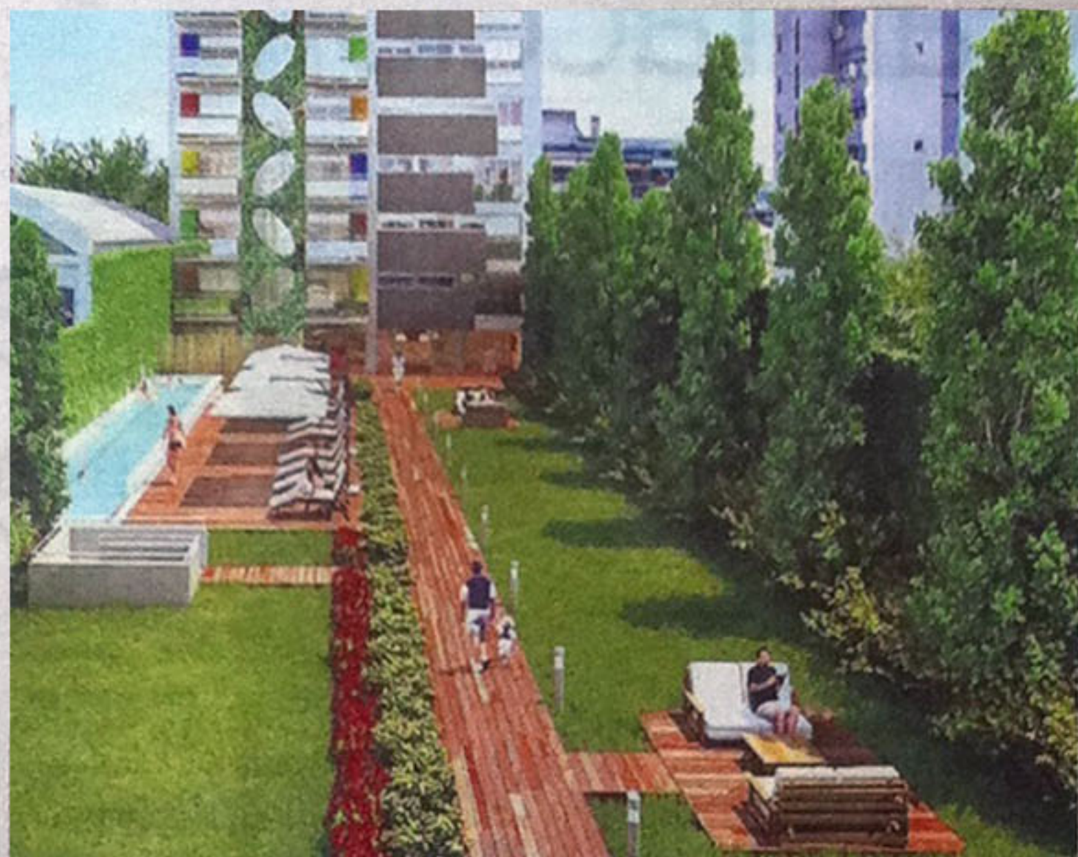
Franja verde. Recorre toda la extensión del edificio.
